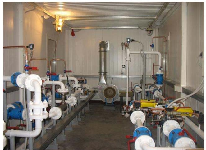
Внутри блок-бокса устанавливаются сигнализаторы загазованности и пожара, взрывозащищенные электроотопители, осветительная арматура и вентилятор.
