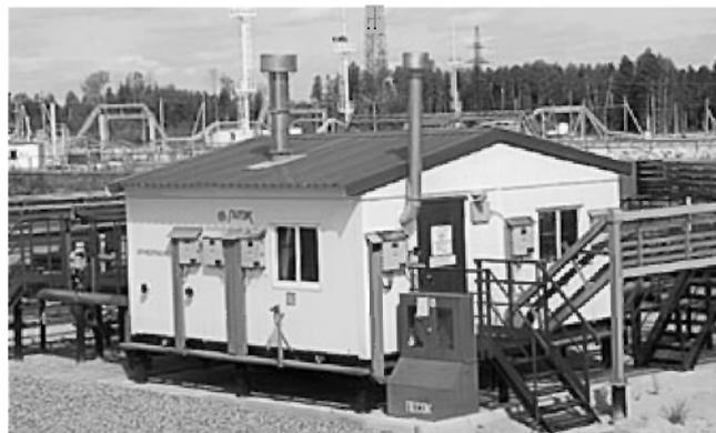
УУН выполняется как открытого исполнения (на рамах), так и в отапливаемых блок-боксах. На площадке заказчика блоки собираются между собой согласно технологической схеме. Единой является и дренажная система. Силовая и контрольная кабельная разводки внутри блоков монтируется на заводе и выводятся на взрывозащищенные клеммные коробки. Внутри блок-боксов устанавливаются сигнализаторы загазованности и пожара, взрывозащищенные электроотопители, осветительная арматура и вентилятор.
